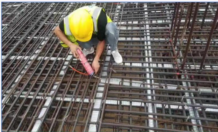
预应力波纹管施工
